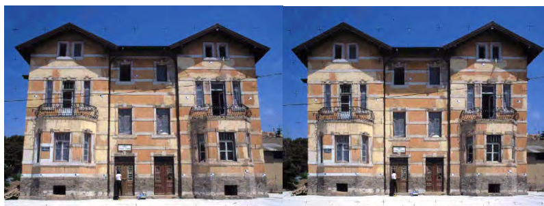
Εικόνα 33. (α). Αρχική εικόνα. Είναι εμφανής η παραμόρφωση που υφίσταται το κτίριο λόγω της κεντρικής προβολής. (β). Τα σφάλματα λόγω κεντρικής προβολής και κλίσης έχουν απαλειφθεί
